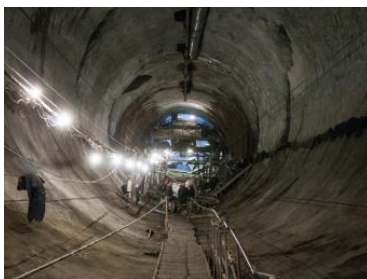
Рис. 6. Будівництво двоколійного тунелю (а) та його макет (б)
