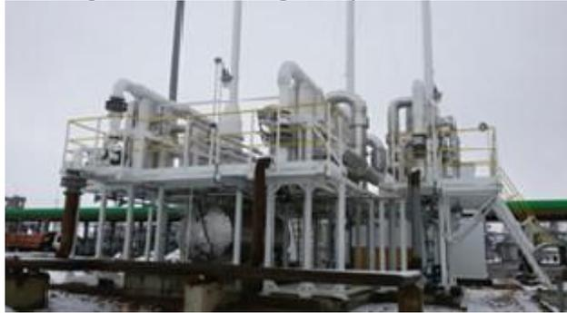
Рис. 1. Комплекс конденсации и рассеивания паров нефтепродуктов ККР-1200
