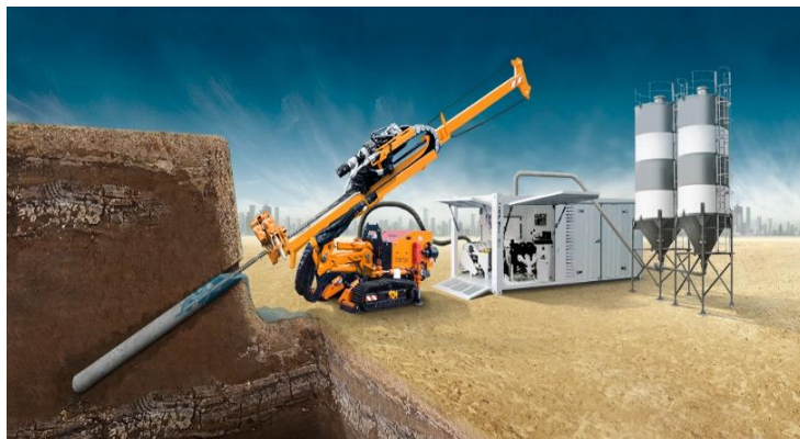
Рис. 4. Технологія jet grouting
