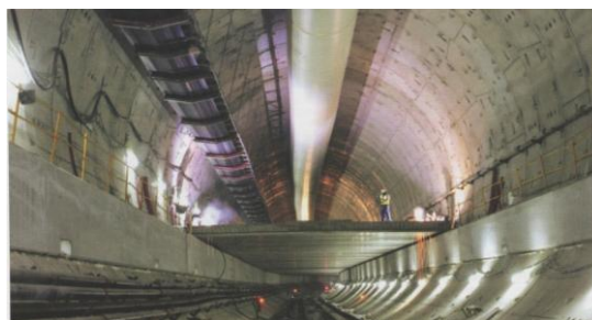
Рис. 5. Будівництво дворівневого тунелю
