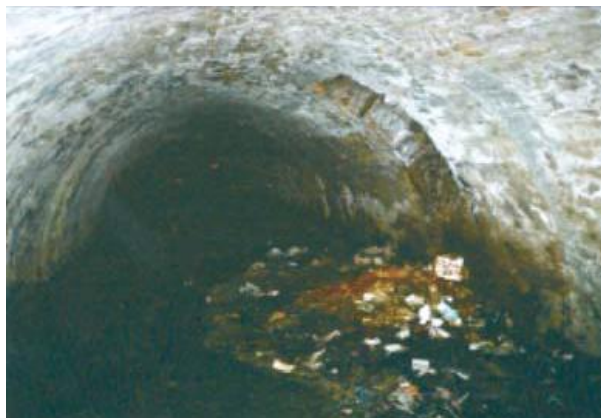
Рис.1. Внутрішня поверхня каналізаційних тунельних колекторів, зруйнована корозією
