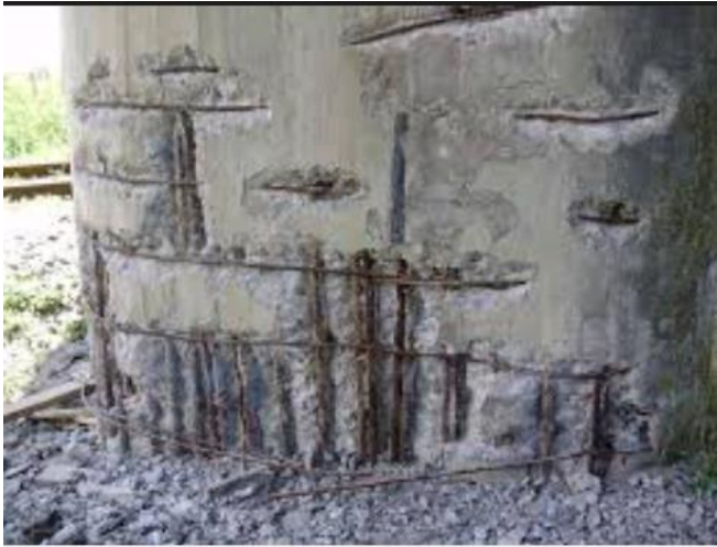
Рис. 1. Корозія залізобетонної конструкції
