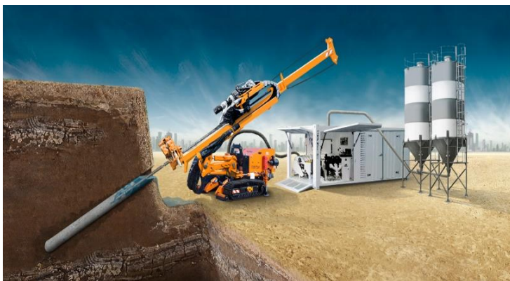
Рис. 4. Технологія jet grouting
