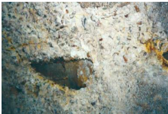
Рис.2. Руйнування обробки і тюбінгу каналізаційних тунельних колекторів в результаті впливу корозії
