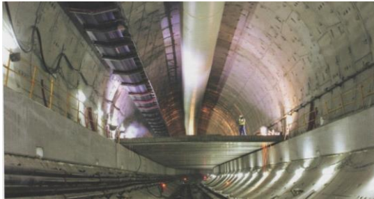
Рис. 5. Будівництво дворівневого тунелю
