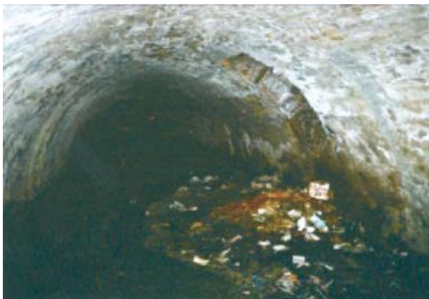
Рис.1. Внутрішня поверхня каналізаційних тунельних колекторів, зруйнована корозією
