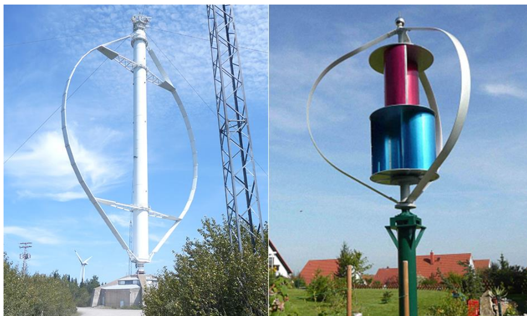
Рисунок 2. Види вітрових турбін з вертикальною віссю: а- найвища в світі вітрова турбіна, що виконана у вигляді ротора Дар'є; б- комбінована конструкція (ротор Дар'є та ротор Савоніуса)
