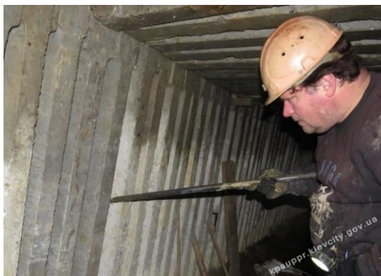
Зображення 1 – Технологічний догляд за дренажною галереєю (3) КП "Спеціалізоване управління протизсувних підземних робіт" | (Facebook)
