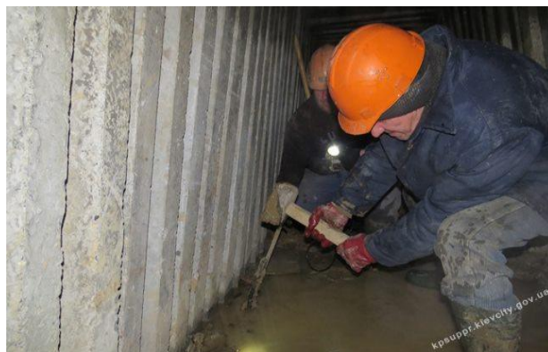
Зображення 1 – Технологічний догляд за дренажною галереєю (3) КП "Спеціалізоване управління протизсувних підземних робіт" | (Facebook)
