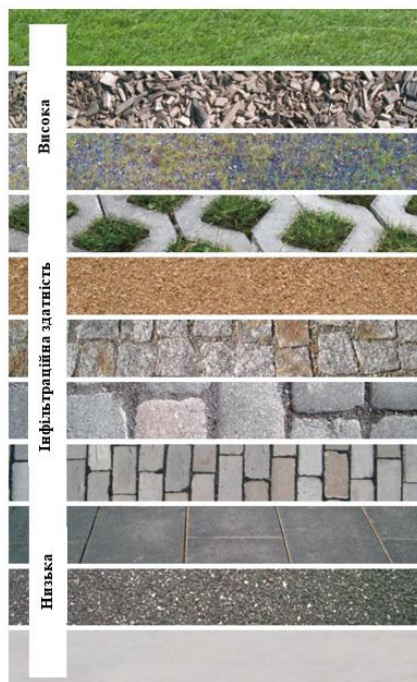
Рис. 4. Негерметичні та частково герметичні водопроникні поверхні дозволяють місцевим опадам просочуватися і сприяють поповненню підземних вод
