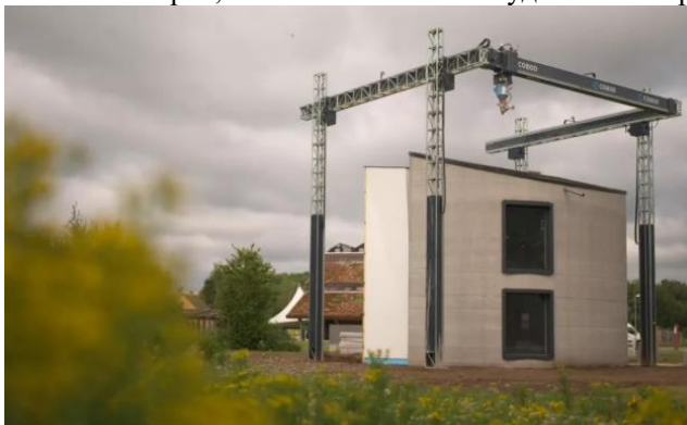
Рис 1. Принтер BOD2 компанії COBOD. Друк здійснюється цементним розчином
