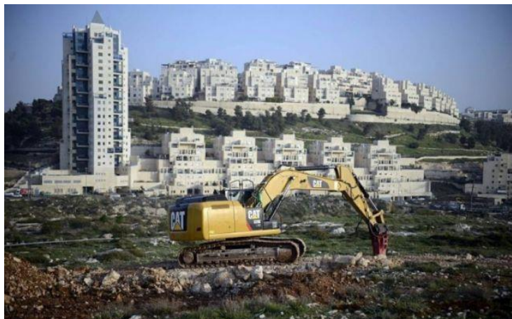
Рисунок 5 - Будівництво укриттів та бомбосховищ в Ізраїлі, з використанням складної техніки та технологій
