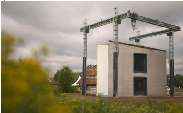
Рис 1. Принтер VOD2 компанії SOBOD. Друк здійснюється цементним розчином
