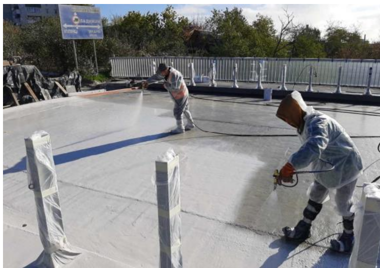
Рисунок 1 – Нанесення методом розпилювання еластомірного шару Eliminator РТА гідроізоляційної мембрани Eliminator
