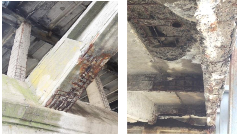
Рисунок 2 – Характерні корозійні пошкодження залізобетонних конструкцій мосту
