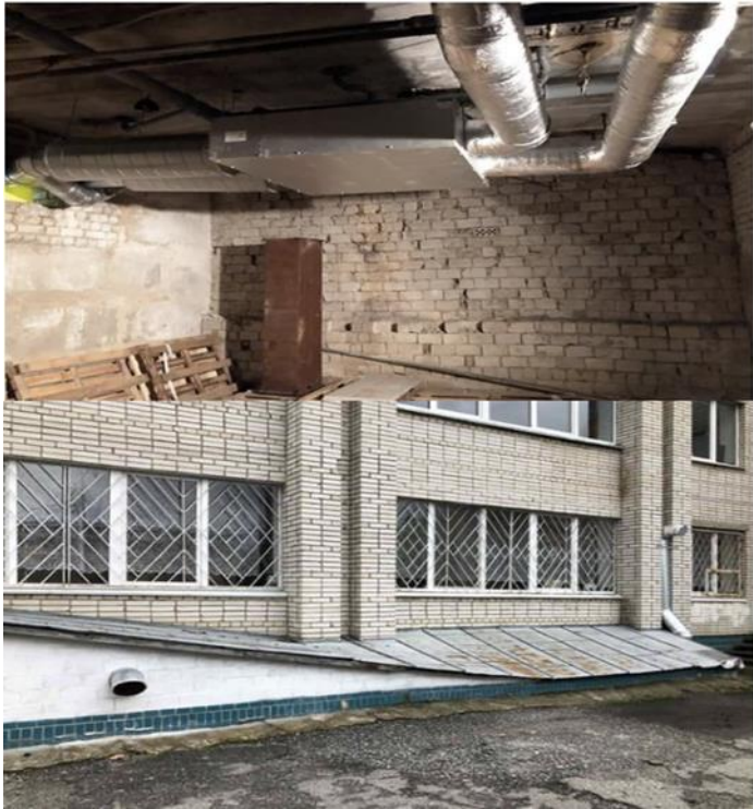
Рис. 2 Приклад припливно-витяжної система з рекуперацією тепла та догріванням повітря
