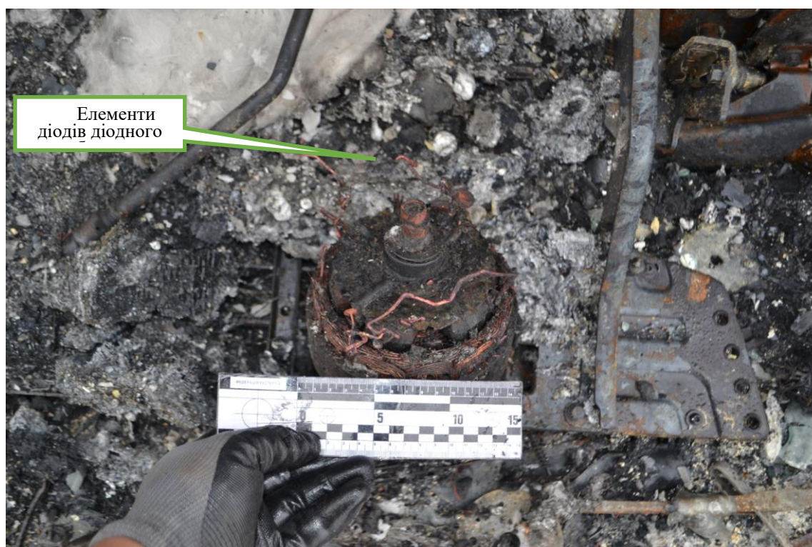
Рис. 3. Все, що залишилось від генератора.
