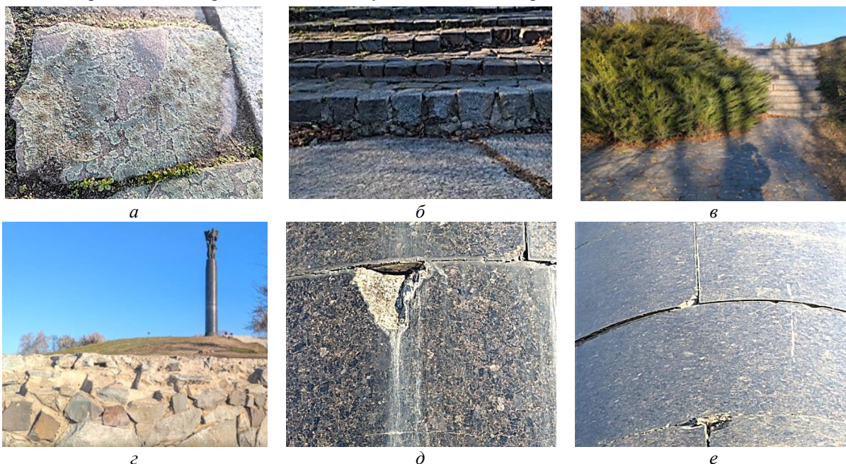
Рис.1. Стан архітектурно будівельних виробів Монументу Слави м. Житомир:
