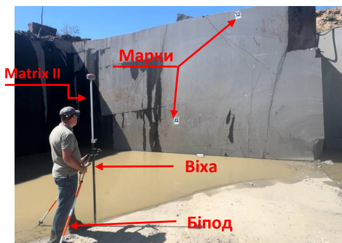
Рис. 3. Виконання знімання центрів контрольних марок GNSS приймачем Matrix II від компанії AlphaGEO за технологією SMART Laser RTK
