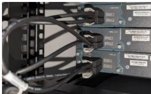
Рисунок 2 - Кільцева топологія стеку Cisco Catalyst 2960-SF
