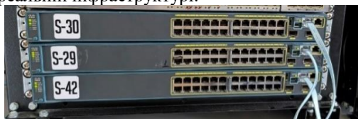
Рисунок 1 - Стек комутаторів Cisco Catalyst 2960-SF
